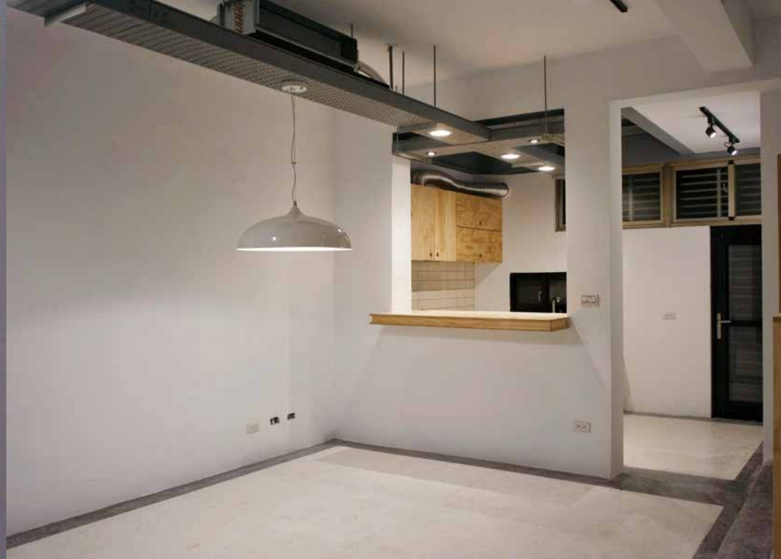
/ 一樓吊隱式冷氣與一、三樓衛浴 /
