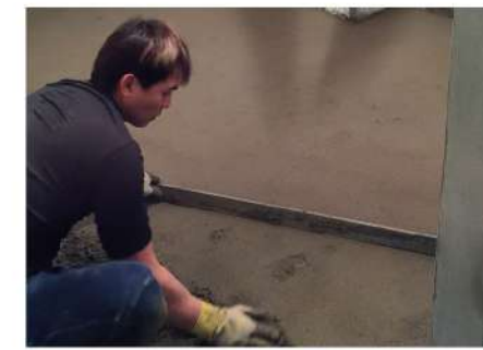
2. 磁磚施工流程-地坪打底
