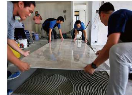
5. 磁磚施工流程-磁磚鋪貼
