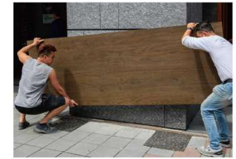
3. 磁磚施工流程-磁磚搬運進場
