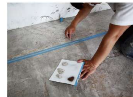
8. 磁磚施工流程-美容填縫
