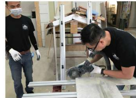
4. 磁磚施工流程-加工裁切
