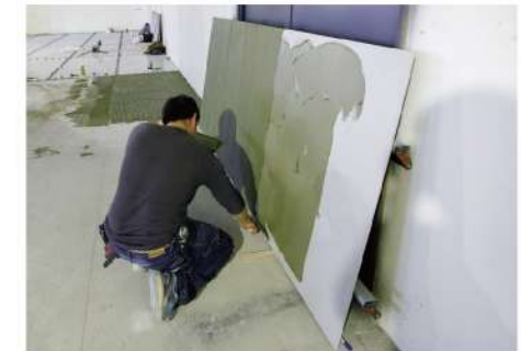
6. 磁磚施工流程-雙面上膠
