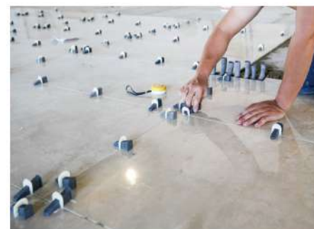
7. 磁磚施工流程-整平器固定
